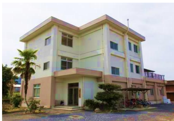
学校の隣、1分もかからない所にある鉄筋3階立ての緑ヶ丘寮
